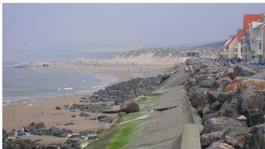
Protection par enrochement mis en place après la tempête de 2007
