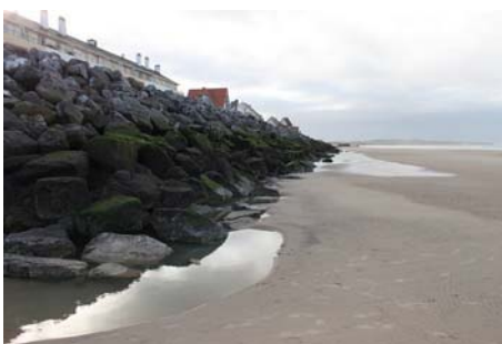
Enrochements suite aux tempêtes de 2007
