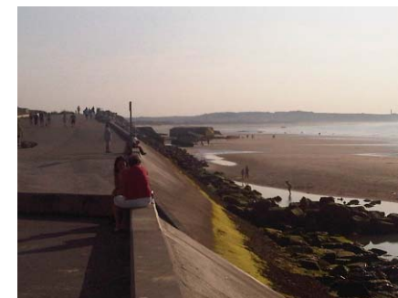
Zone de perré entre la descente à bateaux et la protection en enrochements
