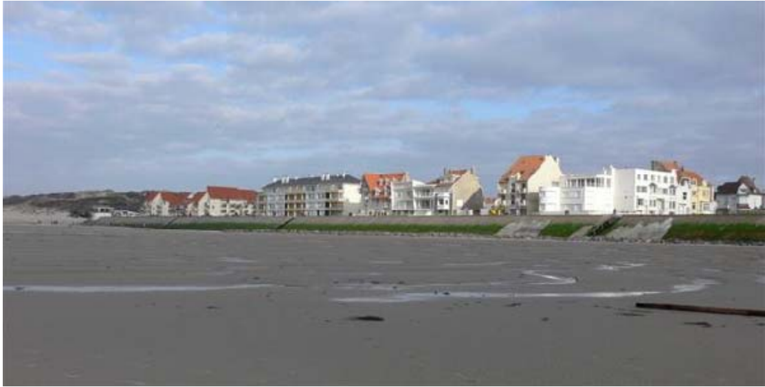
Digue vue de la plage avant les tempêtes de 2007
