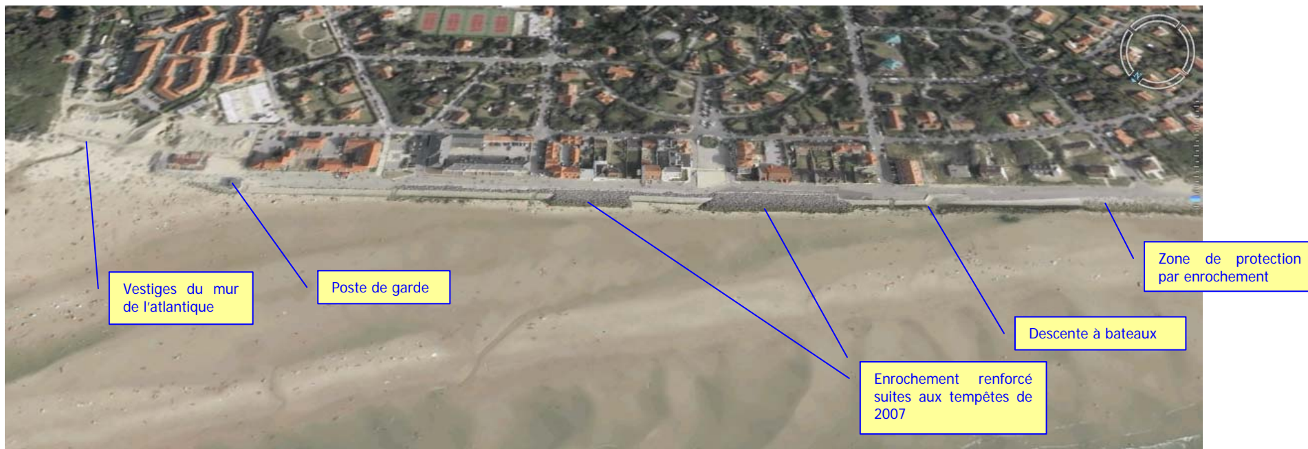
Vue aérienne de la digue à partir de la mer (source : géoportail 3D)
